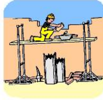
Fig. 11: Falta de orden y limpieza
